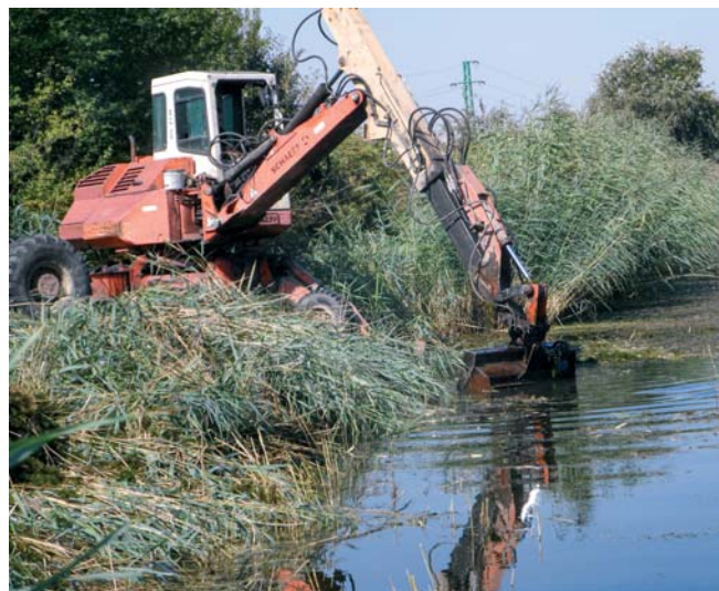
SVP, š. p. disponuje dostatkom vhodnej techniky na údržbu hydromelioračných kanálov.
